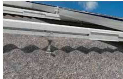
Dettaglio: vite STSI con staffa SSP
