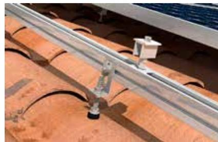
Dettaglio: vite STSR con staffa MW SA
