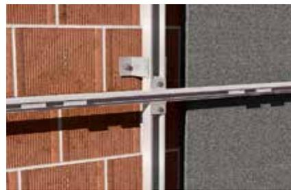
Dettaglio: collegamento al montante
