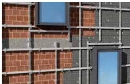
Sottostruttura di facciata ventilata
