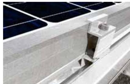
Dettaglio: fissaggio del modulo fotovoltaico
